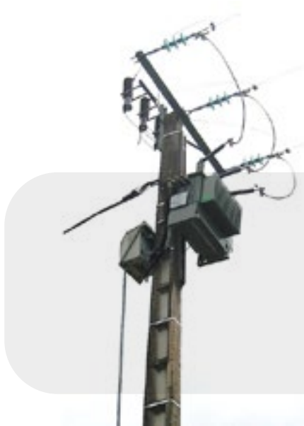
Detalle aplicación en ALTO poste de Hormigón y/o metálico para proteger transformadores de 50, 100 o 160 kVA
